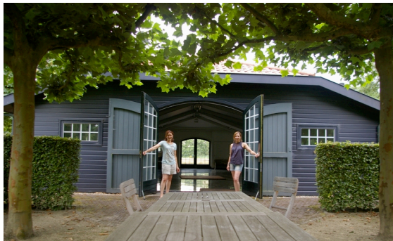
Welkom in de Ruimte!
